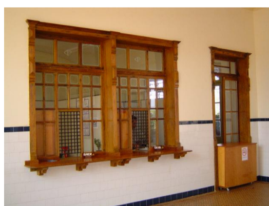
Bilheteria da Estação
